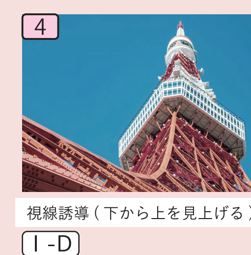
視線誘導（下から上を見上げる） I-D
